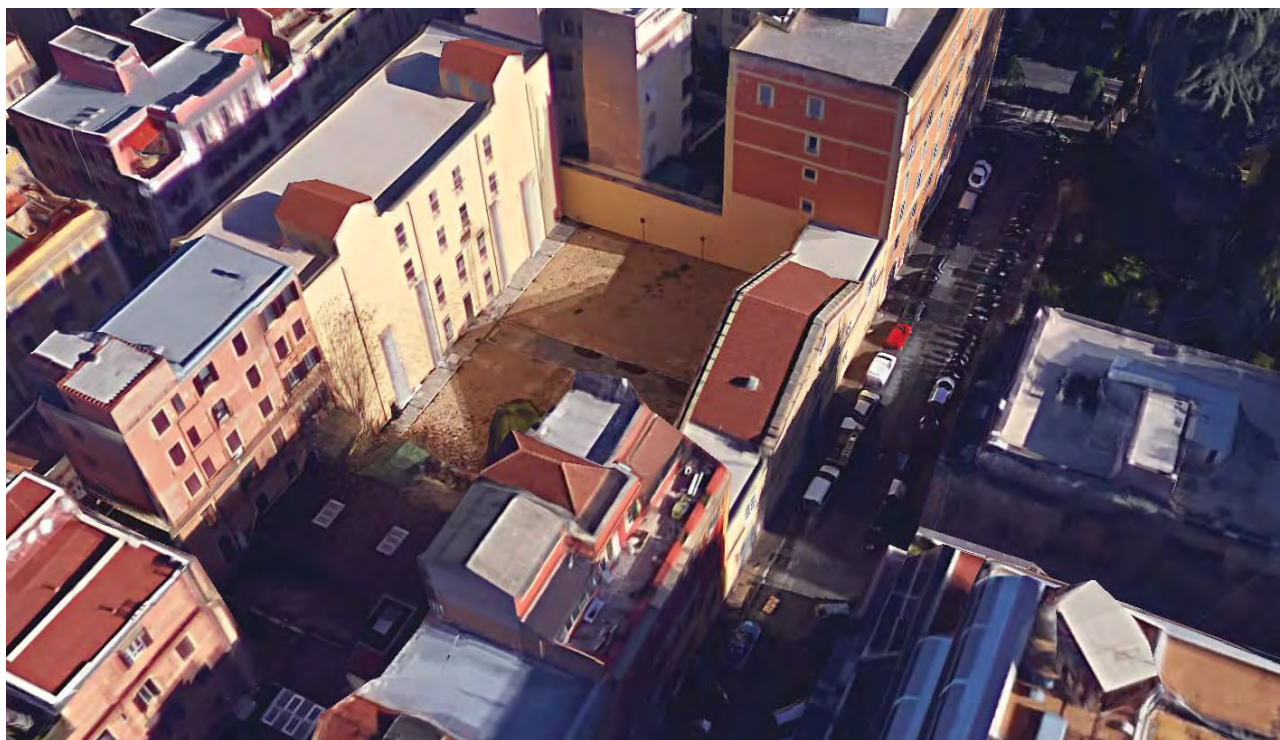
Il cortile interno, un tempo occupato da una copertura sorretta da sei travi Polanceau poggiate su muri di spina ove oggi rimangono solo le tracce di spiccato lungo le pareti verticali interne.
