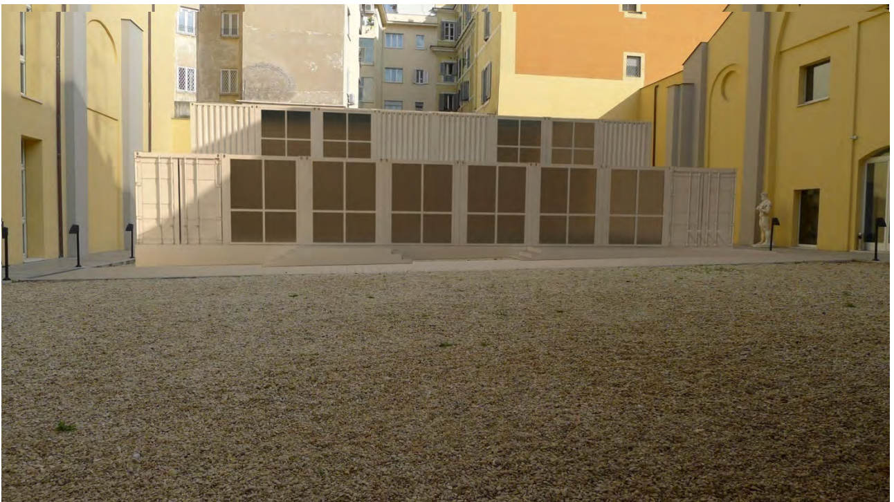
Veduta da sud-ovest verso nord-est
