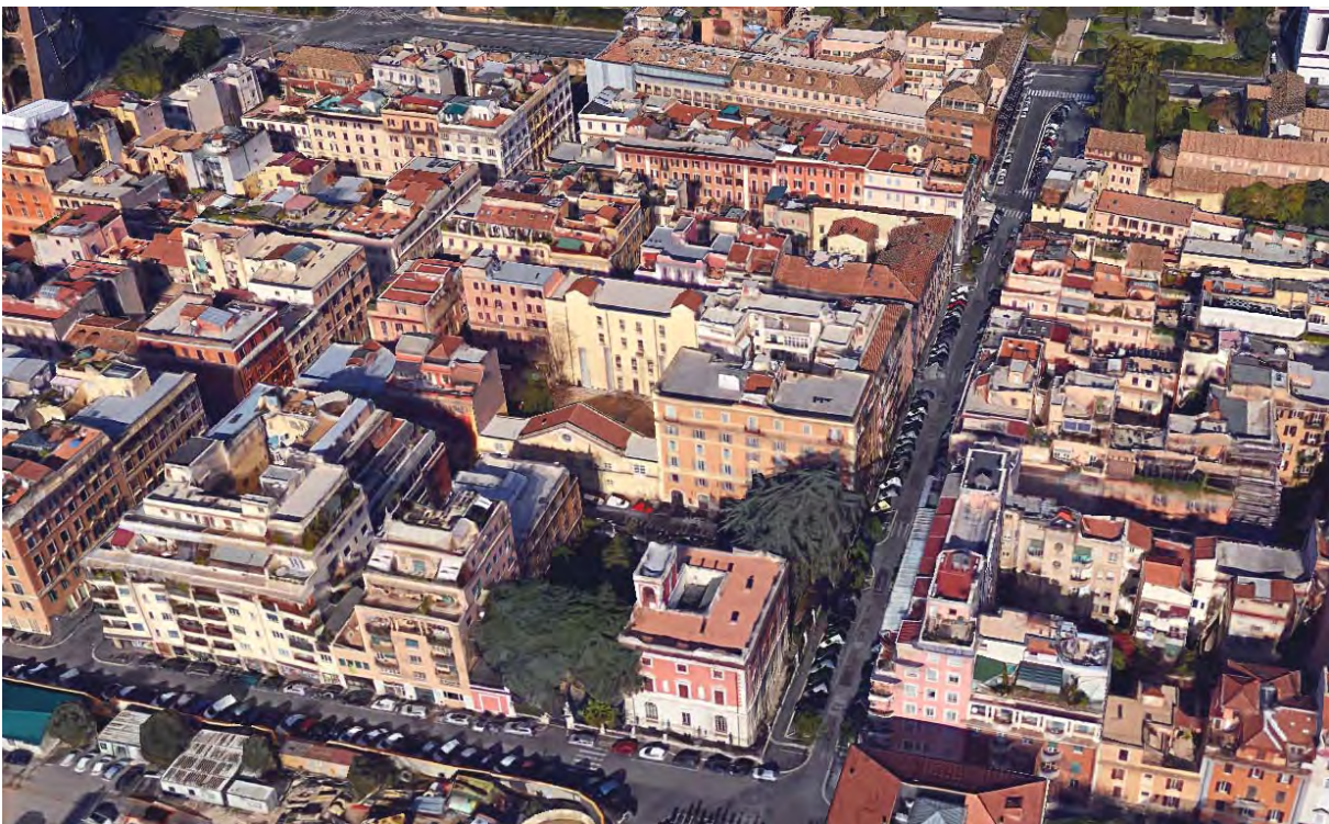
Vista da sud ovest dell'isolato. L'edilizia è disposta sul fronte strada con all'interno cortili e affacci interni
